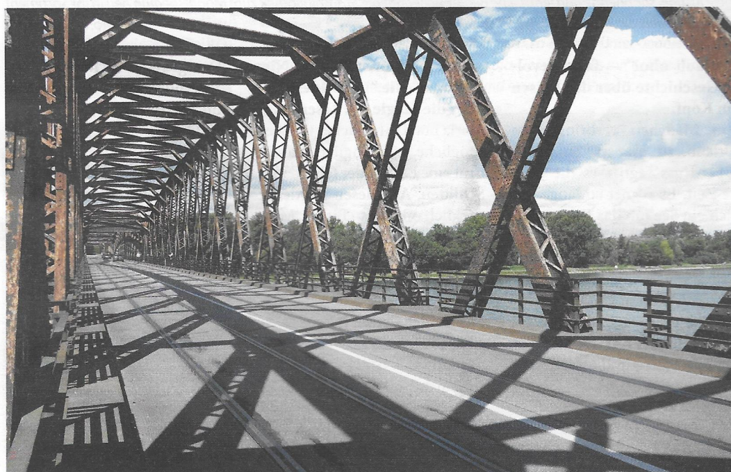
Die Bahnschienen auf der Brücke sind erhalten geblieben.
