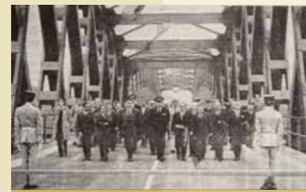
Ein historischer Moment! 1960 wird die Brücke für die zivile Nutzung freigegeben. Kreisarchiv Rastatt, BNN vom 27. August 1960. Un moment historique! En 1960, le pont est rendu à l'utilisation civile. Archives du district de Rastatt, BNN du 27 août 1960.
