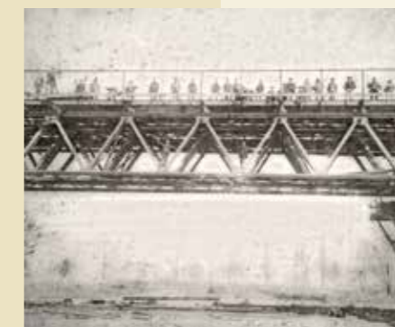
Die Vorlandbrücke auf der badischen Rheinseite, 1894. Stadtarchiv Rastatt
