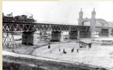
Die Belastungsprobe der Brücke wurde mit 7 Lokomotiven durchgeführt, 1895. Stadtarchiv Rastatt
