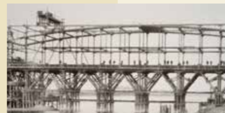
Die Arbeiten waren sehr gefährlich. Mind. 3 Arbeiter verloren ihr Leben, 1893. Stadarchiv Rastatt
