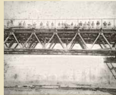
Die Vorlandbrücke auf der badischen Rheinseite, 1894. Stadarchiv Rastatt
