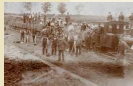
Bauarbeiten an der Streckenführung, Wintersdorf, 1894. Kreisarchiv Rastatt
