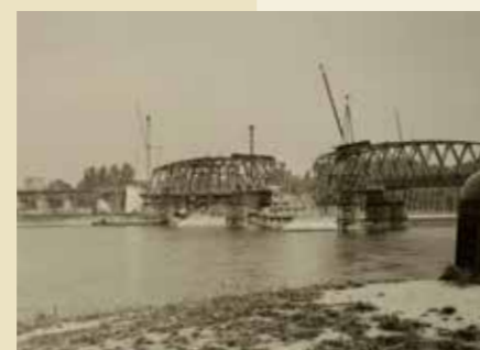
Mit den Kranbrücken wurden die Brückenbogen in Position gebracht, 1941. Kreisarchiv Rastatt, Sammlung Dr. Johannes Werner Les ponts de grue permirent de mettre les arches en position, 1941. Archives du district de Rastatt, collection de Johannes Werner
