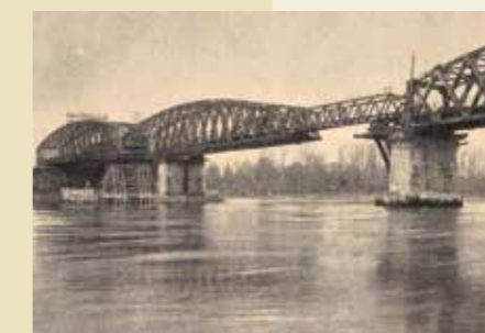
Der mittlere Brückenbogen wird installiert, 1949. Kreisarchiv Rastatt, Le Metier, 2/1949 Installation de l'arche centrale, 1949. Archives du district de Rastatt, Le Metier, 2/1949
